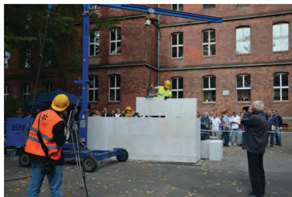
Pokaz firmy Xella Polska Sp. z o.o. na terenie Zespołu Szkół Budowlanych w Szczecinie
